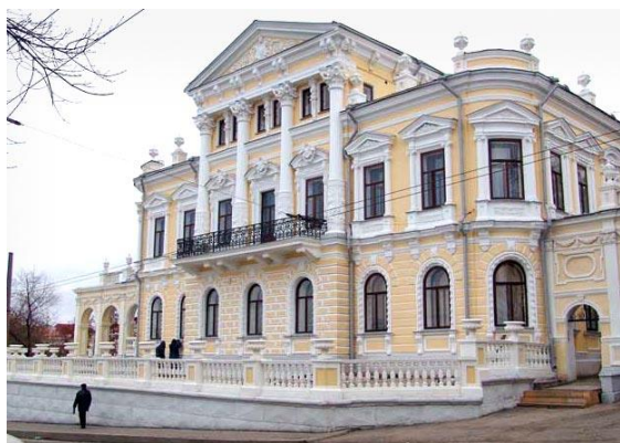
Рис. 1. Дом Н. В. Мешкова по адресу: Пермь, ул. Монастырская, 11
